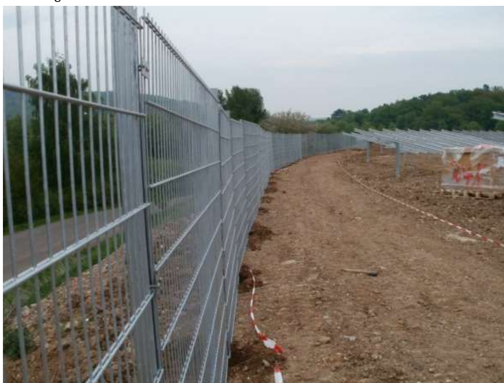
Errichtung der Zaunanlage
