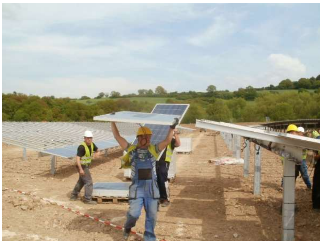
Montage der Solarmodule
