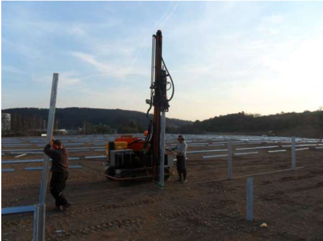
Einrammen der Stahlträger
