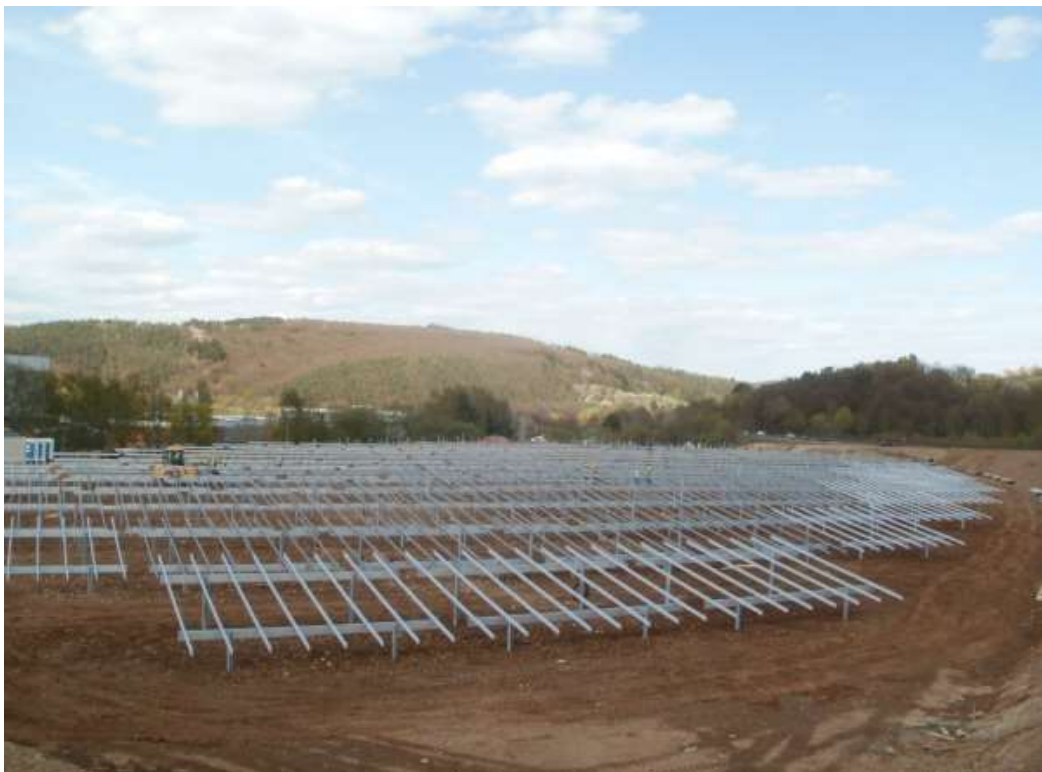
Erstellung der Stahl-Unterkonstruktion
