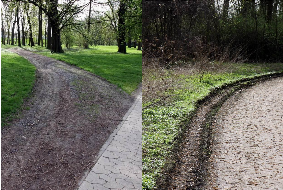
Abbildung 36: Schäden an Wegen und Vegetationsrändern durch Befahren, Neuwied April 2013 (Foto: Andreas Koppelman)
